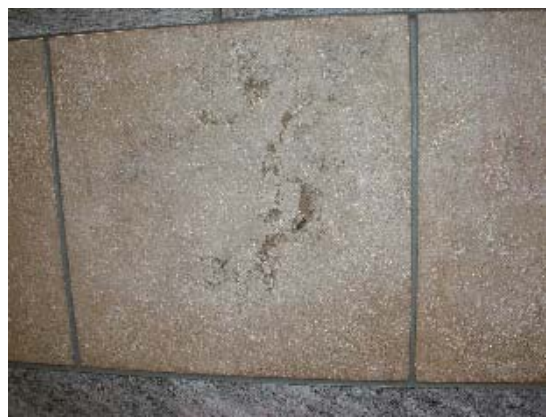
Foto: Dortmunder Stadtwerke
