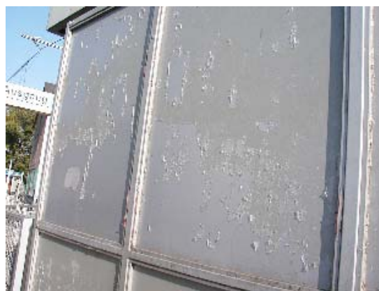
Foto: Dortmunder Stadtwerke
