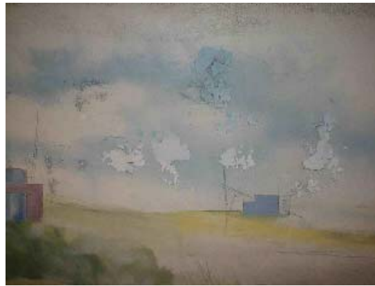
Foto: Dortmunder Stadtwerke
